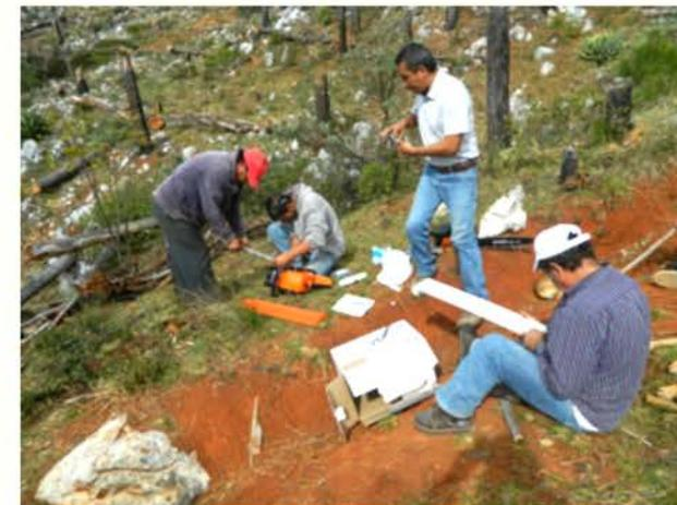
Aunado a la obra, se hicieron 16.4 hectáreas de acordonamiento con material muerto, esto con la finalidad de evitar la erosión del suelo: en un área afectada por un incendio hace años, se utilizaron los troncos quemados para realizar barreras a curvas de nivel. Esta obra se realiza para evitar que se arrastre el suelo; las barreras van formando capas de suelo y en esto se establece vegetación nativa.
